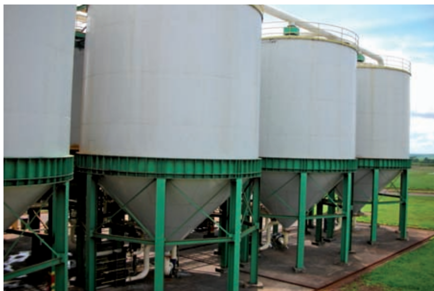
A pintura em unidades sucroenergéticas é uma prática exigida em lei, para alguns setores da usina, ou que leva em conta apenas questões estéticas ou de conservação dos equipamentos
