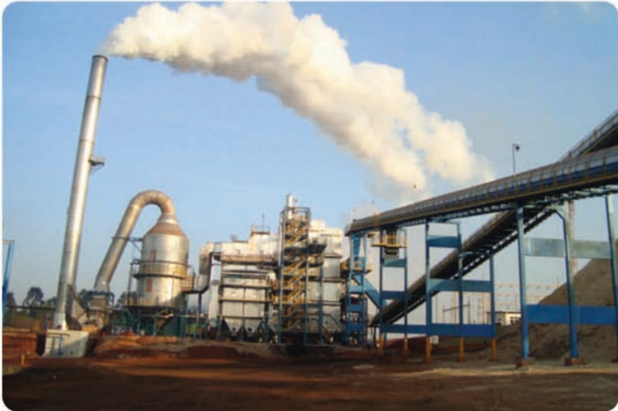
Central Termelétrica Ibitiúva – Tractebel Energia, Pitangueiras-SP, com potência instalada de 33 MW.
