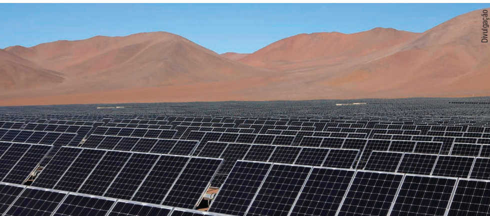
Imagem da Usina Amanhecer (100 MW), no deserto do Atacama, no Chile
